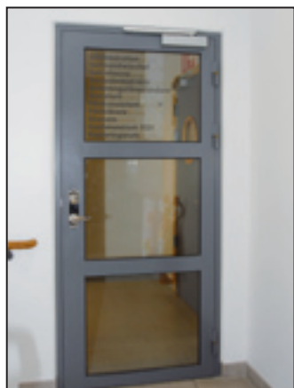
Principkonstruktion enkeldörr brandklass EI 30 och inbrottskydd klass 3 enligt ENV 1627. Partiet kan skyltas enligt Typgodkännandebevis 1946/89 utfärdat av SITAC.
